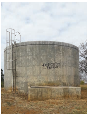
Foto 5: Poço de Mualadzi
